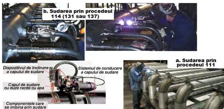
Fig. 2.26. Realizarea îmbinărilor sudate la poziție ale serpentinei cuptoarelor folosind: a. sudarea (manuală) prin procedeul 111; b. sudarea orbitală (automată) prin procedeul 114 (131 sau 137)
